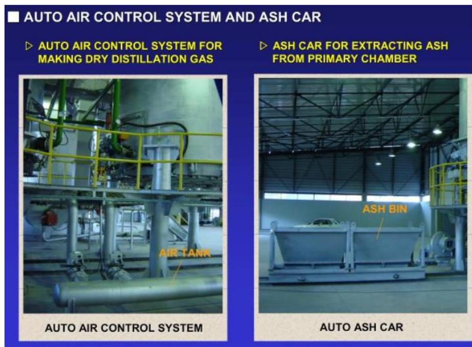
**Gambar 9 Pengatur Udara dan Pengambilan Abu Otomatis**
