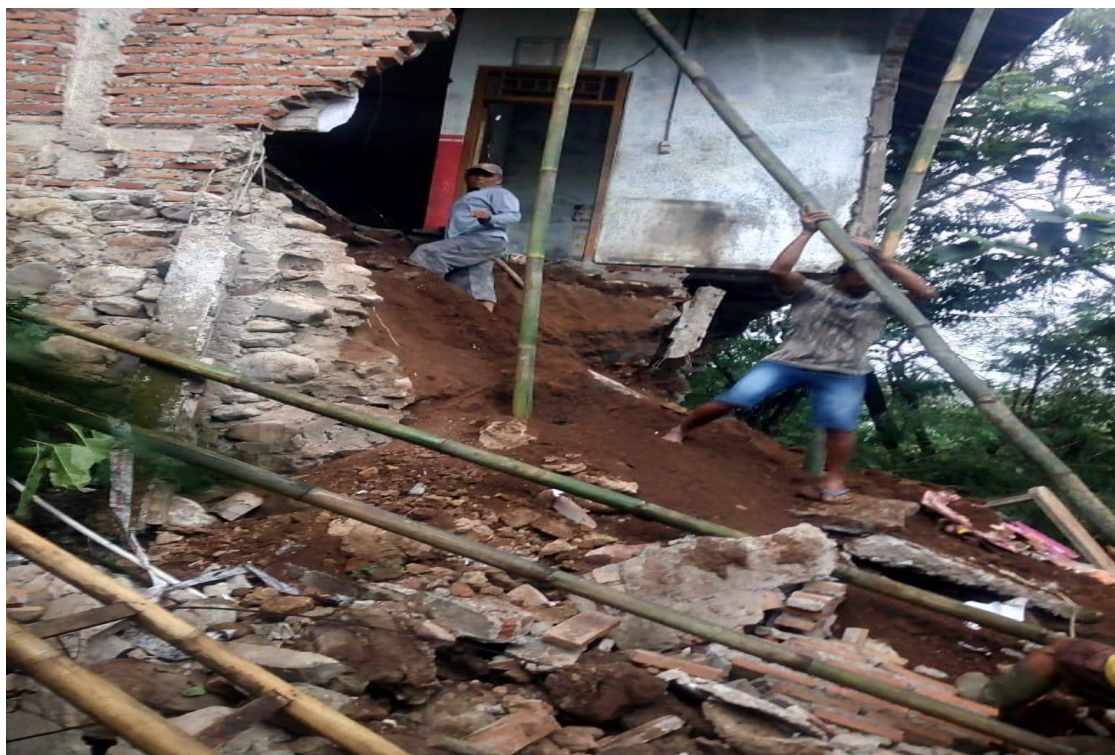
Gambar 3.4 Bencana Tanah Longsor di Desa Gunungwungkal Kecamatan Gunungwungkal 11 Desember 2020
